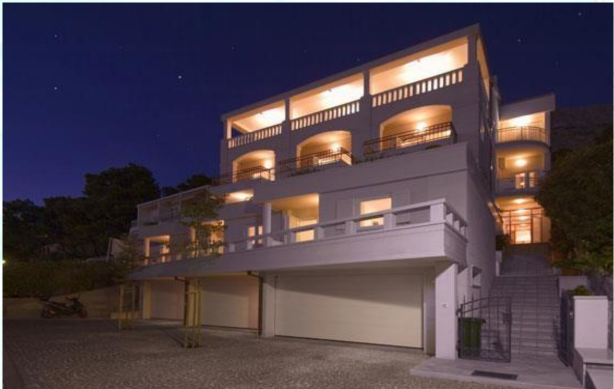
Der Balkon mit Schmiedezaun im 3.OG
